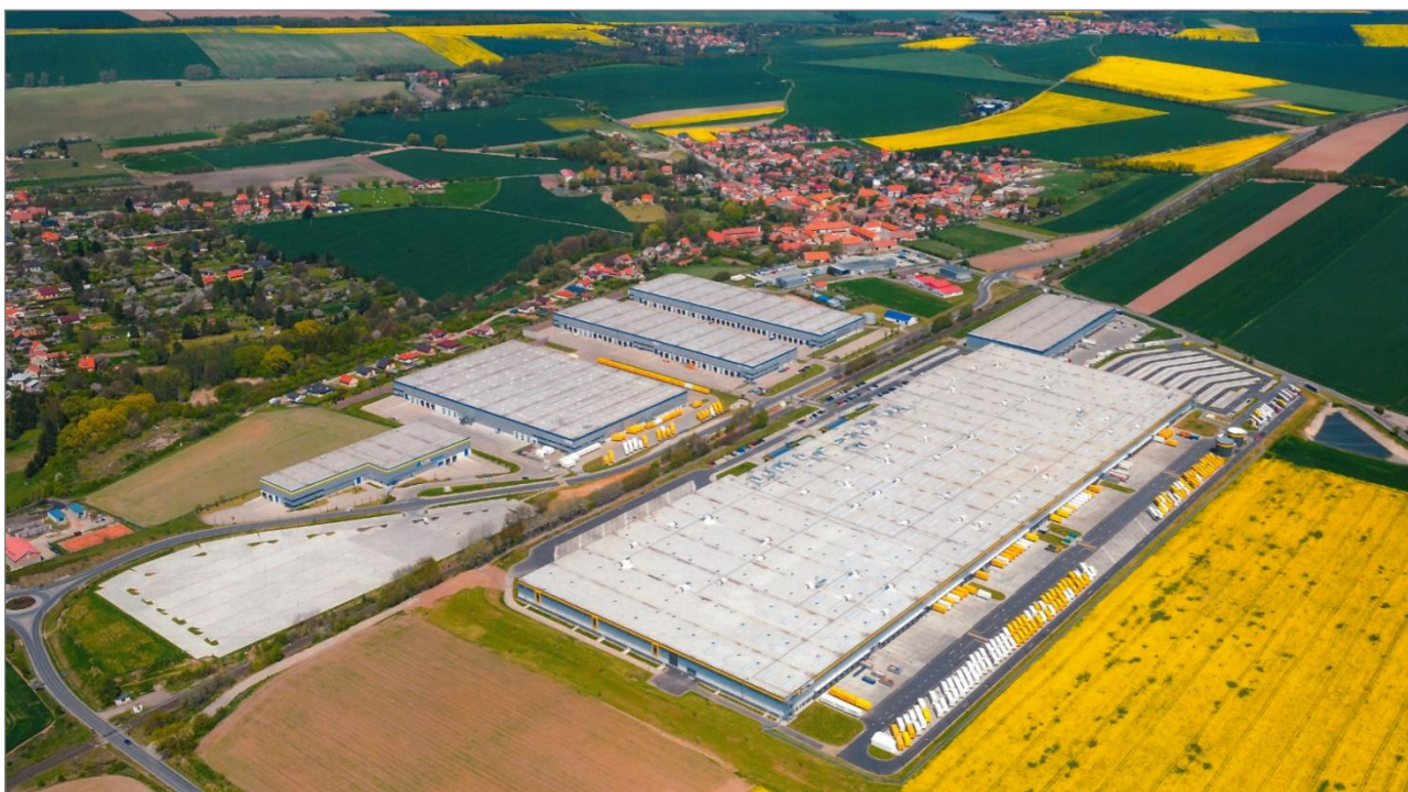
Mimořádně necitlivé umístění průmyslové zóny v Dobrovízi v krajině i ve struktuře osídlení západně od Prahy (foto: Tomáš Hora, THC)
