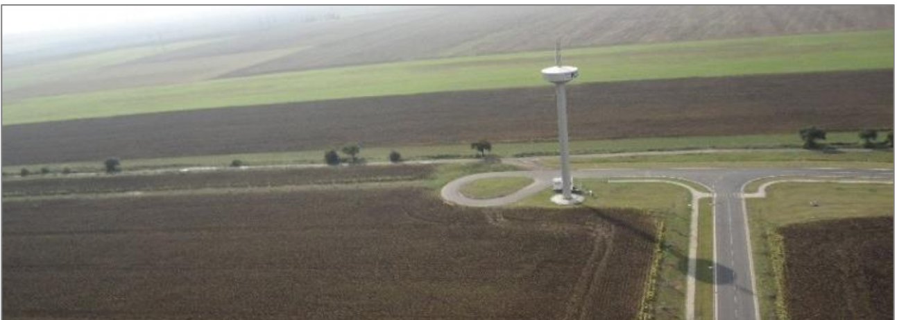
Vodojem pro zásobení Průmyslové zóny Joseph u Mostu pitnou vodou (zdroj: zazijzmenu.cz/cile-trasy/strategicka-prumyslova-zona-joseph-230)
