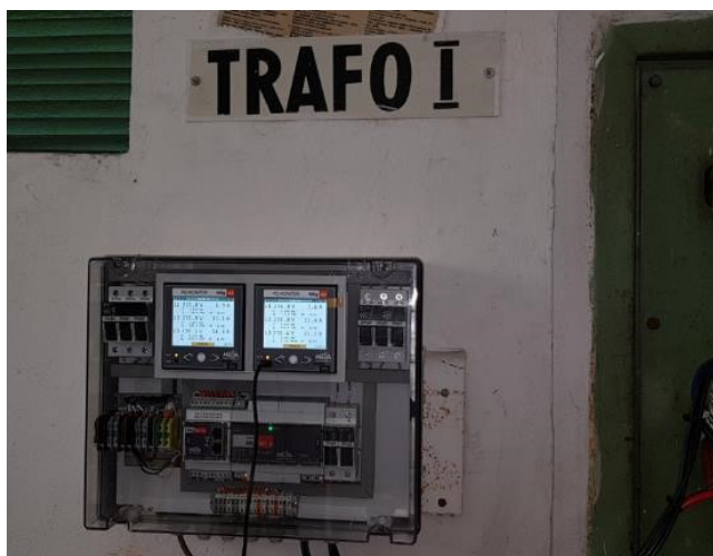
Příklad reálného nasazení PQ monitoru MEg44PAN pro české energetické distribuční společnosti
