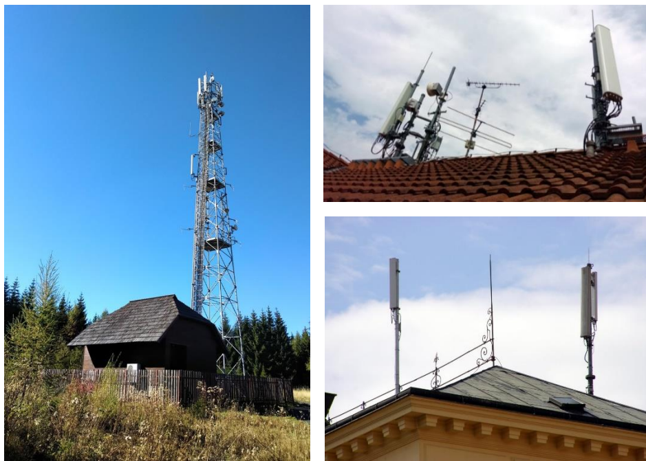
Obrázek 3: Různé podoby antén BTS
