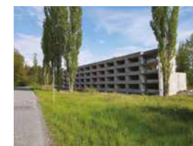
Opuštěné budovy v bývalém výcvikovém vojenském prostoru Milovice – Mladá
