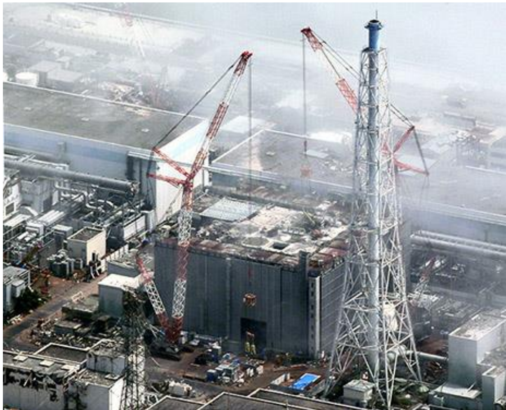
Obrázek 16: Fukušimská elektrárna, demontáž budovy reaktoru č. 3, 2.8.2015 (zdroj: http://ajw.asahi.com/article/0311disaster/fukushima/AJ201508020026 )
