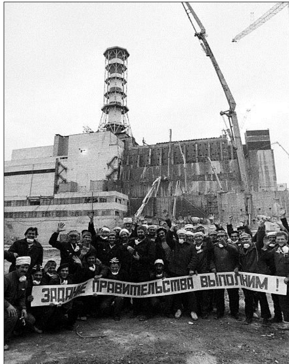
Obrázek 15: Poškozená elektrárna v Černobyli, pracovníci stavějící sarkofág reaktoru, 11/1986 „Úkol vlády splníme“ (zdroj: http://www.20min.ch/wissen/news/story/17233299 )
