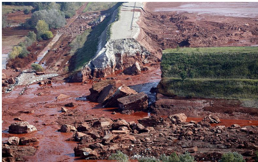
Obrázek 5: Protržení hráze nádrže u města Ajka (zdroj: https://commons.wikimedia.org/wiki/File:Ajka_accident_d38e36f0e9_b.jpg )
