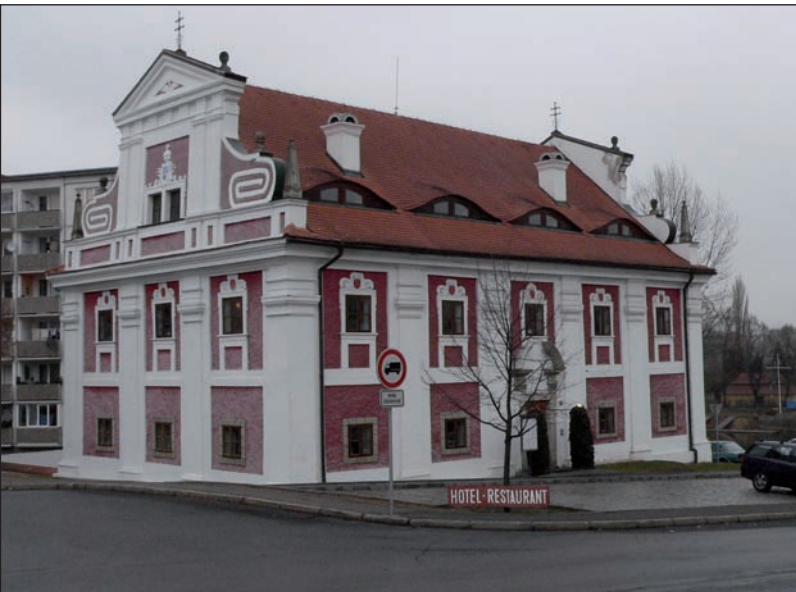
Starý barokní špitál, architektonická perlička v rekonstruovaném kabátě (nad parkem a nad řekou před branami královského města Louny)
