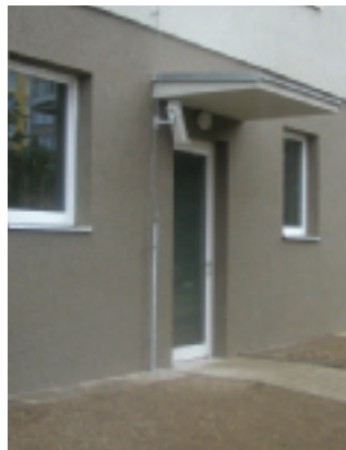
Kamera u zadního vchodu do objektu
