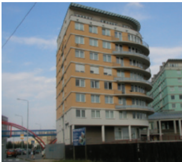
Nová výstavba bytových domů
