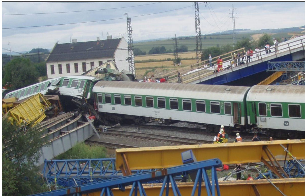
Místo nehody, vpravo na zbytku tělesa mostu probíhá třídění zraněných.
